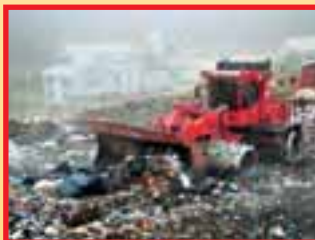
Razkladanje, kontrola in strojno vgrajevanje ostankov odpadkov v odlagalno telo odlagališča v Puconcih
